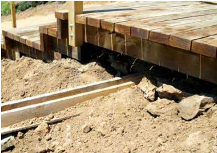
← Des renvois d'eau en bois sont disposés régulièrement sous l'escalier. Ils permettent de bien canaliser les eaux de ruissellements avant que la végétation ne reprenne et que le sol se stabilise.
