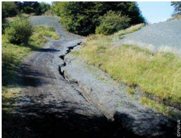
Les chemins sont souvent profilés en auge, l'eau est alors canalisée sur une longue distance et n'est pas évacuée régulièrement. L'eau prend alors de la vitesse et de la force et sa capacité à transporter les matériaux est augmentée. On observe la formation de rigoles (zone de départ des matériaux) et des zones d'accumulation de ces matériaux.
