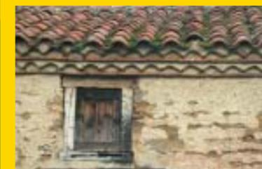
Génoise\*, sous toiture en tuiles creuses
